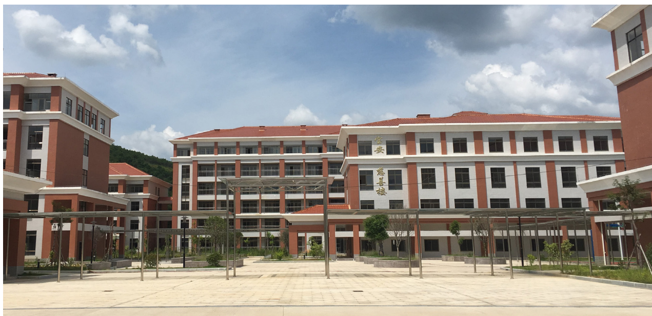
河源市龙川县“三院”建设项目（原县福利院）
