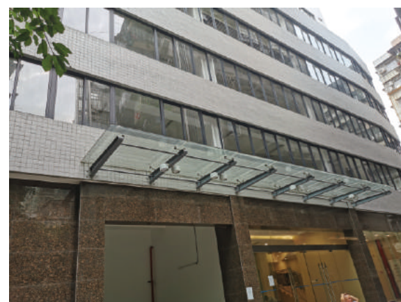
建设中的省福彩数据中心大楼
